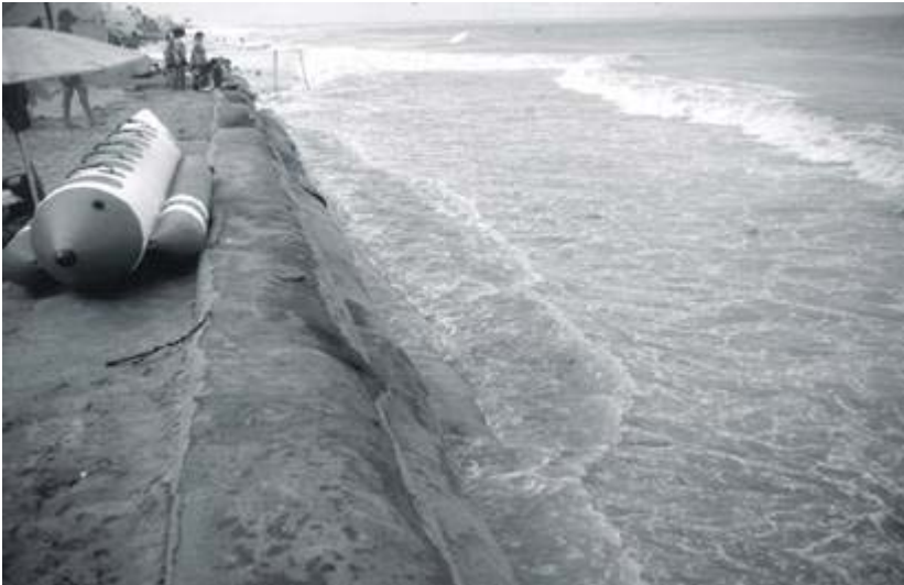
Figura 3: reflexión de olas, generada por los geotextiles
