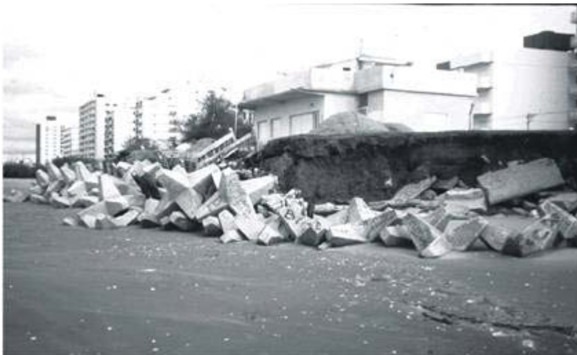
Figura 1: tetrápodos de hormigón
